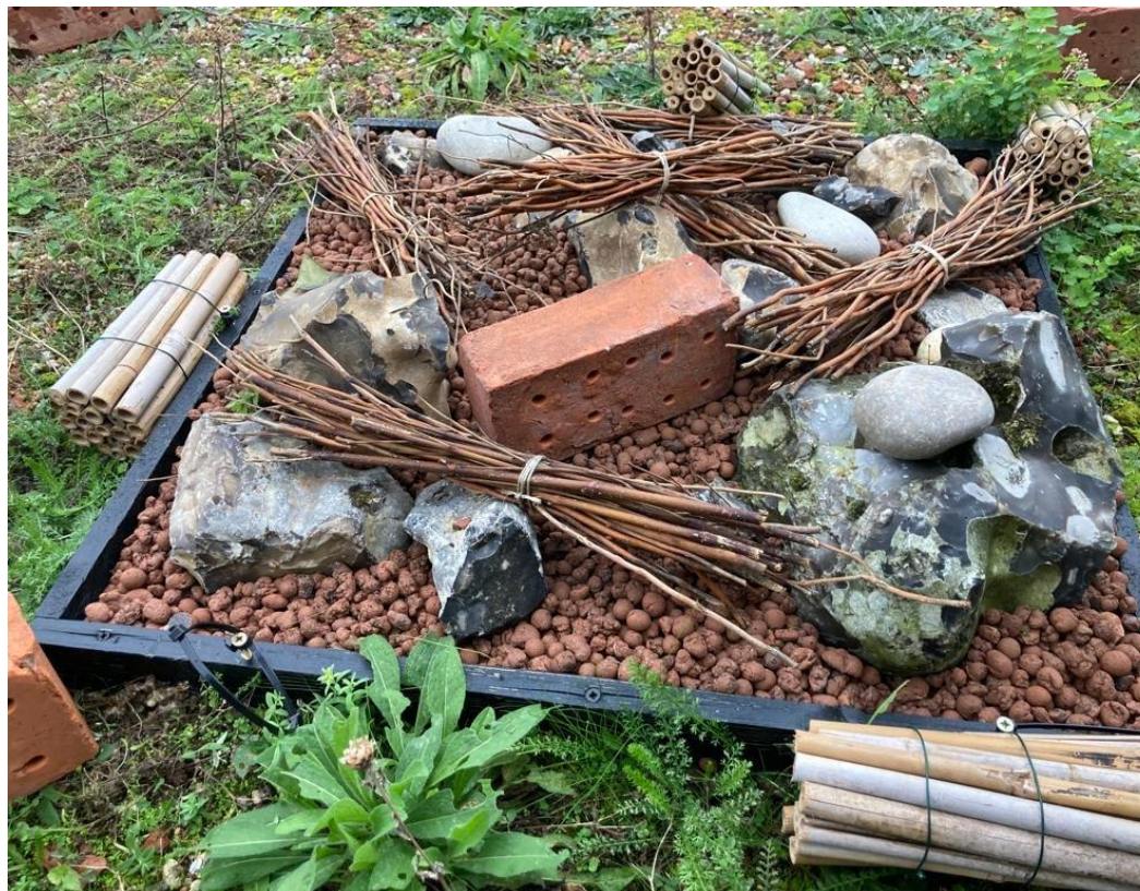
Verschillende voorzieningen voor meer biodiversiteit op het groene dak van One Bedford Avenue. Maatregelen die zijn toegepast: Plantenbakken, Vogelkasten, Bamboestokken voor onderdak bijen, Bakstenen met gaten voor insecten, Rotsen voor schuilplekken voor insecten. Bron: https://www.wildwestend.london/stories-feed/brown-roof-upgrade-one-bedford-avenue
