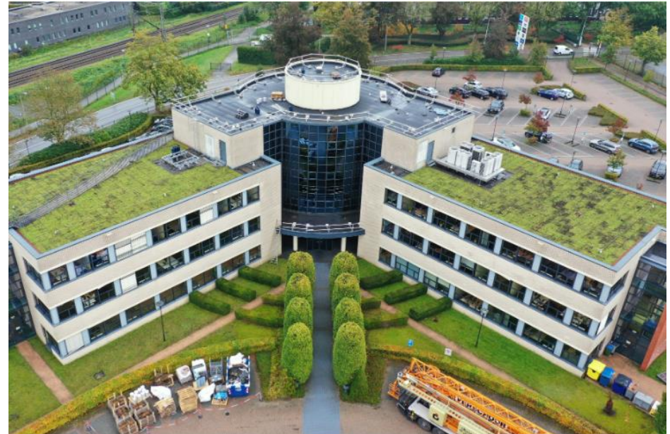
Het nieuwe groendak op het gebouw van Vrumona. Bron: https://www.sempergreen.com/nl/over-ons/nieuws/eerste-nederlandse-detentiedak-voor-frisdrankleverancier-vrumona
